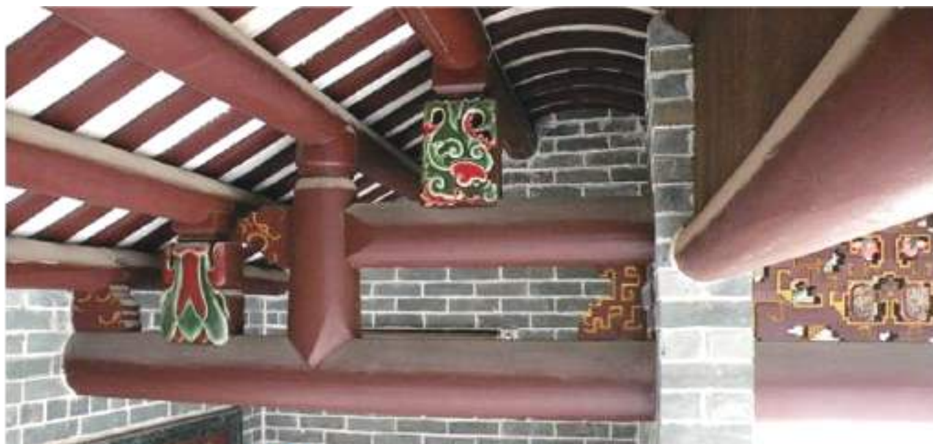
二进天井西廊梁架结构
